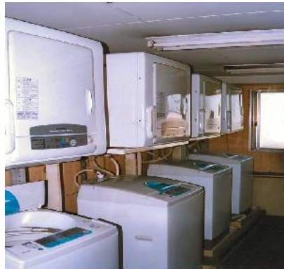
洗濯・乾燥室
